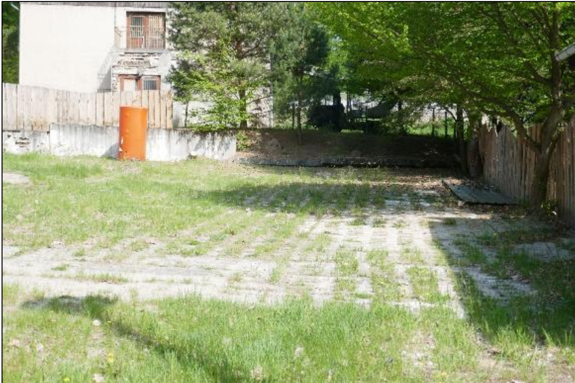
Abbildung 1-31 Anteilig mit Vegetation bewachsene betonierte Parkfläche
