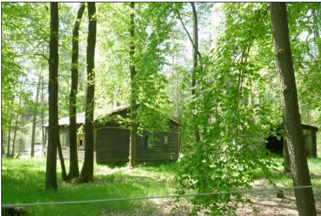
Abbildung 1-26 Eingewachsene ehemalige Kommandantenhütte
