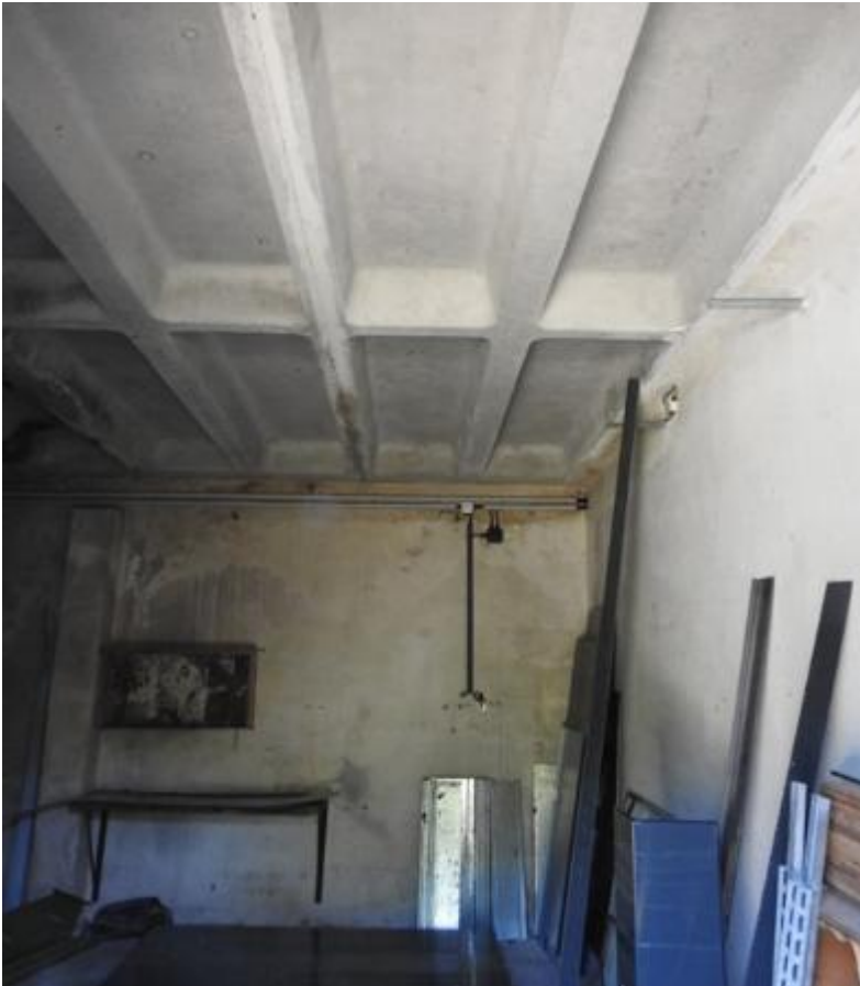
Abbildung 2-4: Deckenbereich der Garagen als Hangplatz (Deckenträger) der Braunen Langohren
