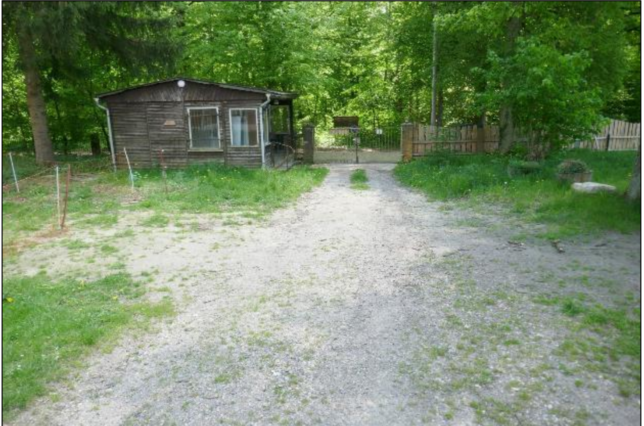
Abbildung 1-34 Schotterweg auf dem Grundstück in Parnitz mit wassergebundener Decke
