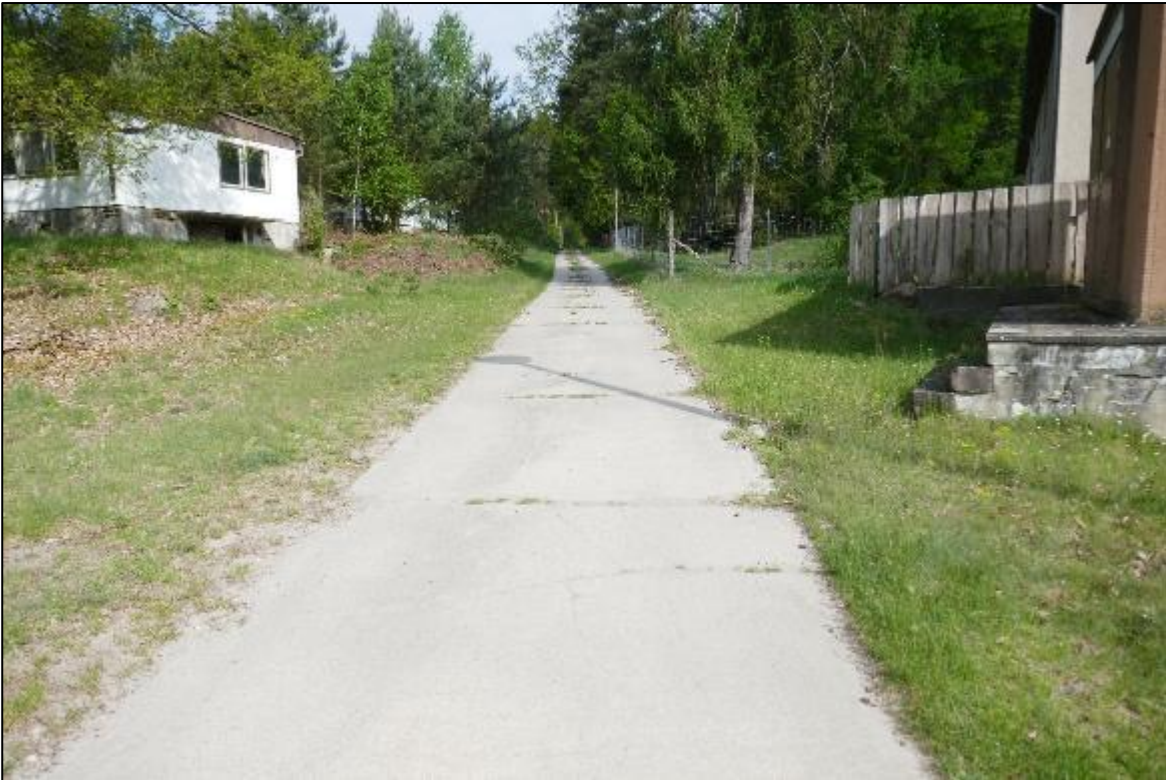
Abbildung 1-35 Betonierter, vollversiegelter Abschnitt des Forstweges
